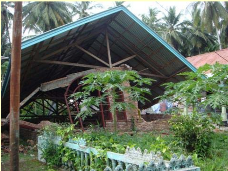
レンガの壁の崩壊による建物の倒壊 (パリアマン市内 10月6日)
