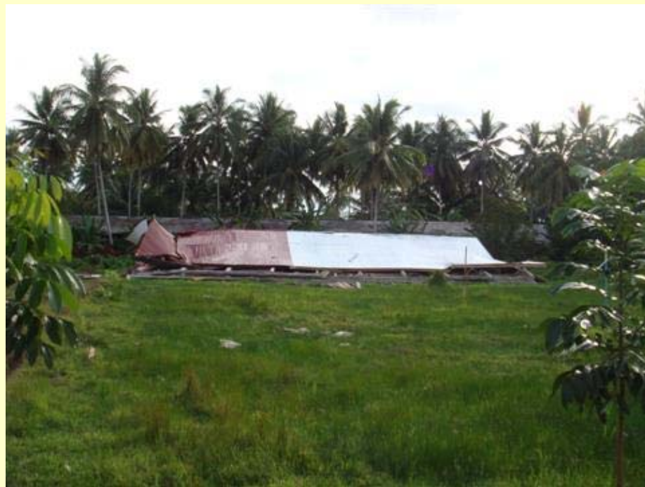
全壊した中学校 屋根は木杵とトタンで軽量だが、 柱が細くて本数が少ない。 (パダンパリアマン県内 10月6日)
